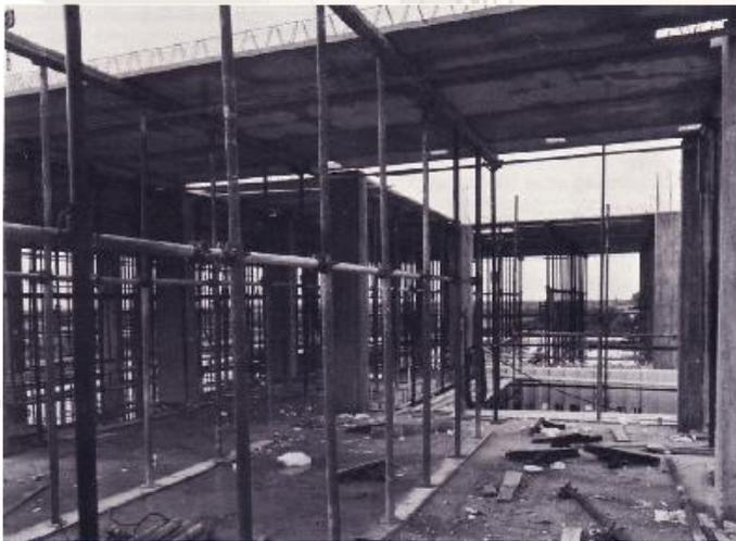
I rompitratta necessari al temporaneo sostegno delle lastre, risultano inferiore per numero a quelli normalmente necessari per sostenere un solaio tradizionale
