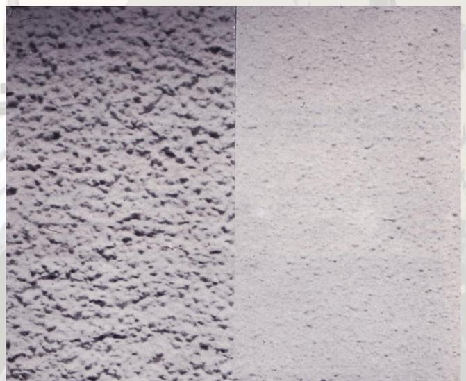
Due diversi tipi di finitura per soffitti realizzati con lastre tralicciate. Queste soluzioni facilmente eseguibili permettono un risultato finale completamente accettabile ed esteticamente elevato.
